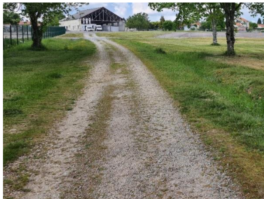
Route couverte d'un peu de végétation – Mai 2022
